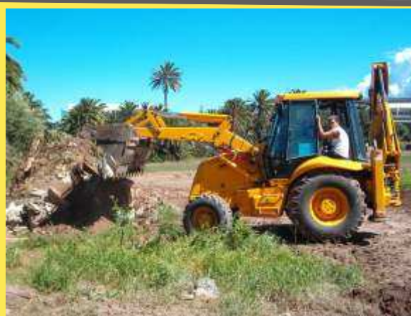
Retirada de escombros en el Campus de Tafira.
